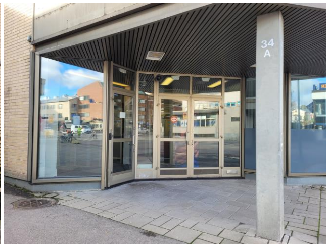
Kuva 34 Järvenpään yritystalon sisäänkäynnit ovat sisäänvedettyjä, ja niissä on alumiinirunkoiset lasiovet. Sisäänkäyntien yläpuolella on katokset, joiden alapinnassa on ruskea paneelimainen alumiiniverhoaus.
