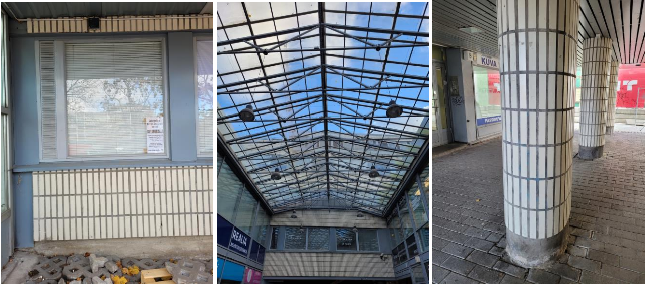
Kuva 39 Sibeliuksenkatu 19:n julkisivun detaljeja ja siipiosien väliin rakennetun katon yksityiskohtia.
