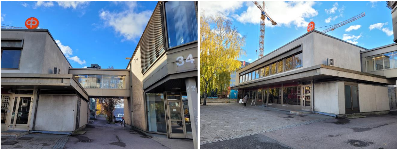
Kuva 25 Yritystalon ja Osuuspankin rakennusten väliin on rakennettu 2000-luvulla ne yhdistävä silta (vasemmalla). Osuuspankin rakennuksen ensimmäisessä kerroksessa sijaitsee kahvilatila. Julkisivussa erottuvin piirre on ensimmäisen ja toisen kerroksen jakava vaakasuuntainen katos (oikealla).
