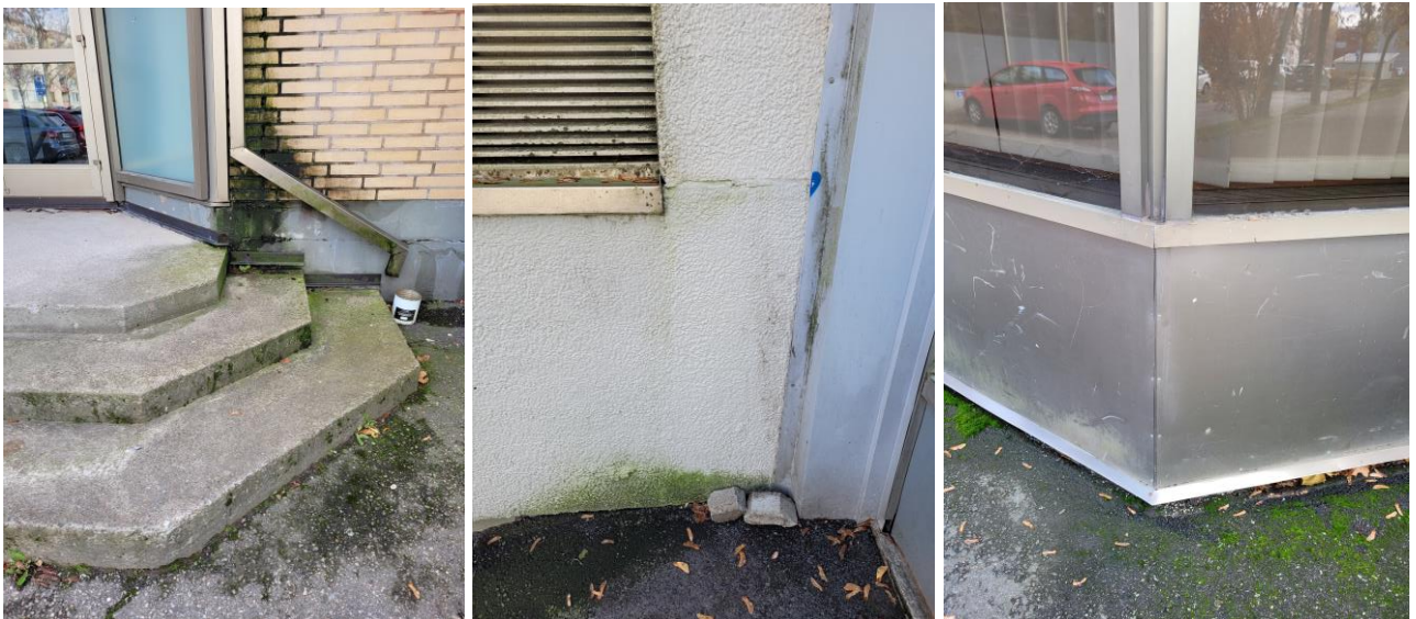
Kuva 36 Rakennuksien julkisivumateriaalien liittymisen yksityiskohtia.
