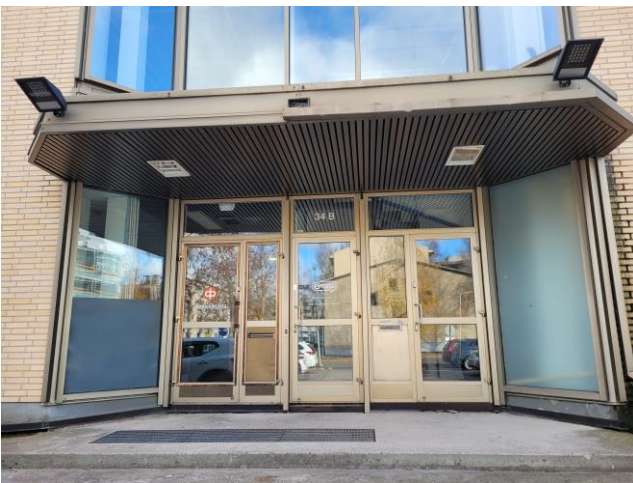
Kuva 34 Järvenpään yritystalon sisäänkäynnit ovat sisäänvedettyjä, ja niissä on alumiinirunkoiset lasiovet. Sisäänkäyntien yläpuolella on katokset, joiden alapinnassa on ruskea paneelimainen alumiiniverhoaus.
