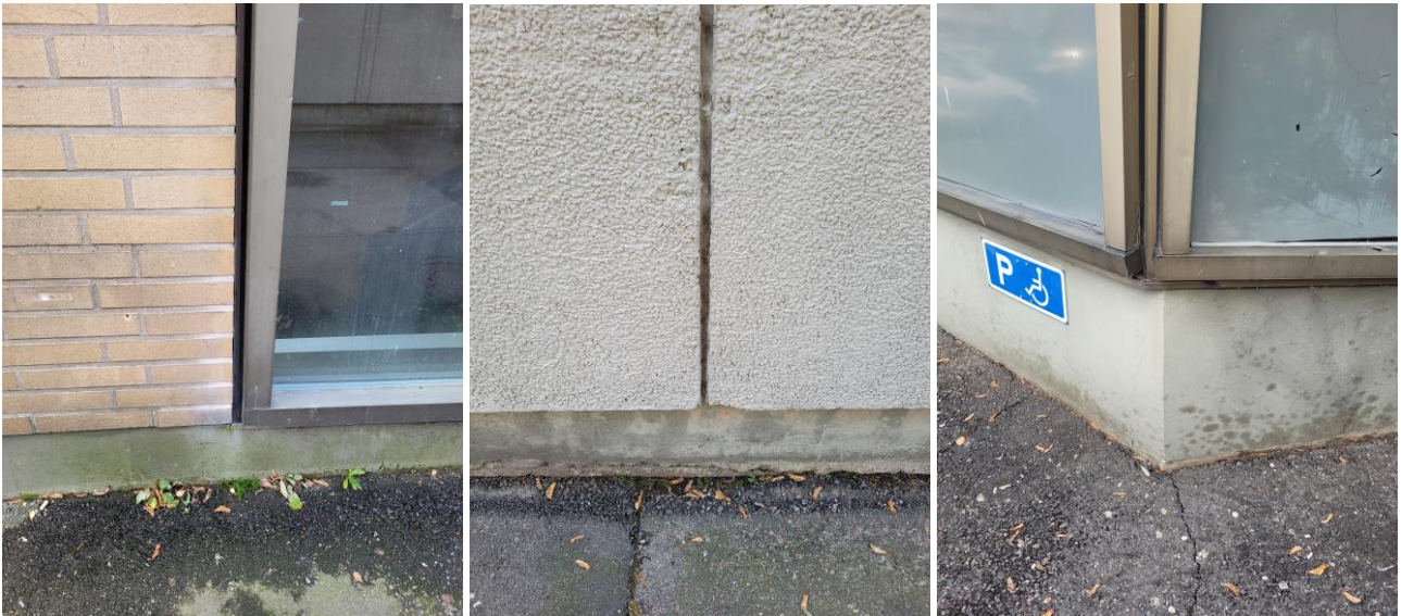
Kuva 37 Rakennusten sokkeliin ja julkisivumateriaalien detaljeja.
