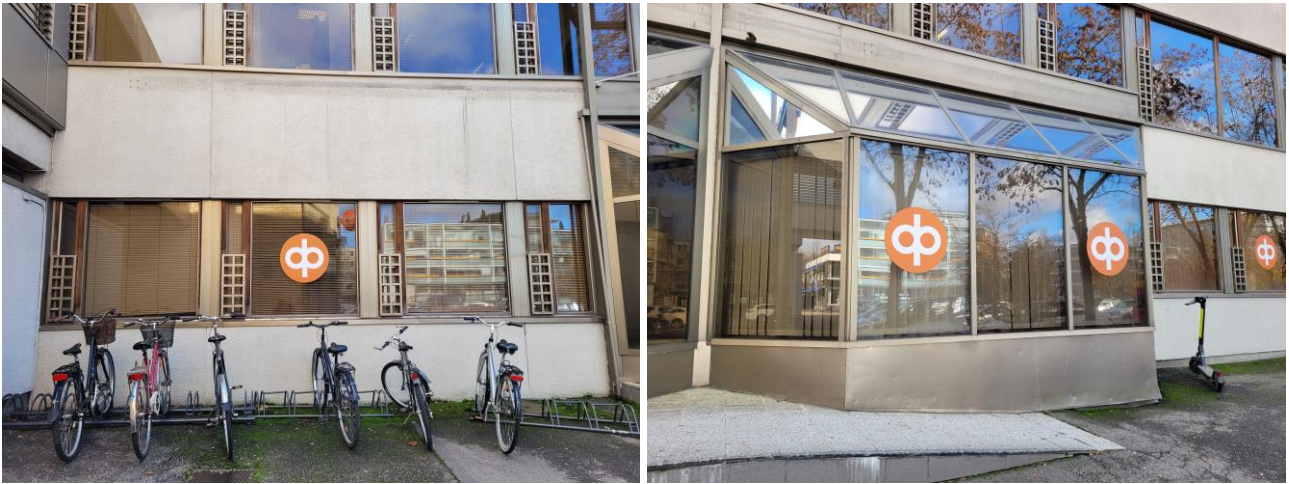
Kuva 35 Osuuspankin julkisivudetaljeissa on niin ikään alumiinisia detaljeja niin ikkunoiden putoamisesteissä kuin niiden puitteissa.
