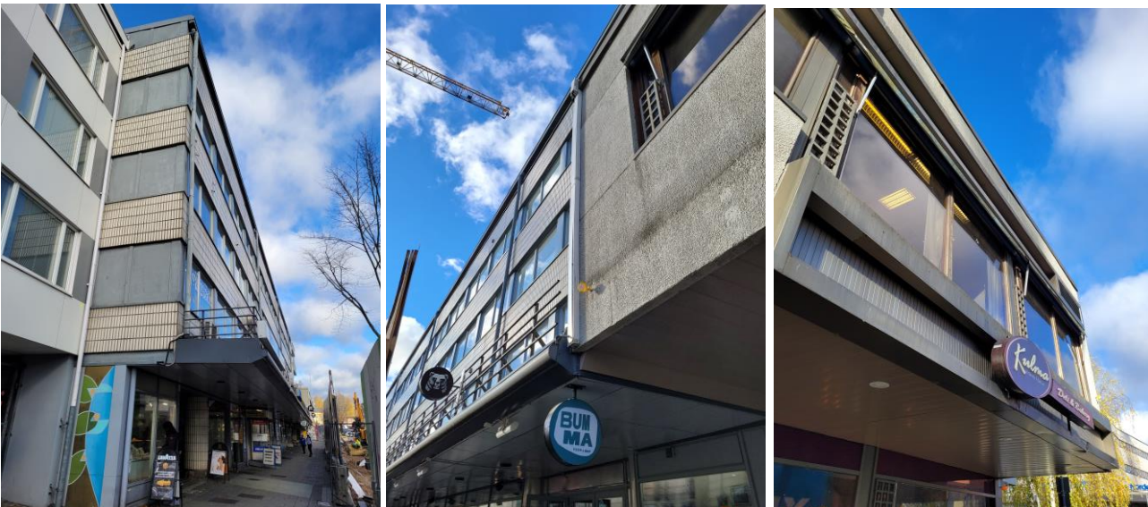
Kuva 40 Sibeliuksenkatu 19 ollut tien varressa alkuperäinen asuinkerrostalo, jonka linjaan myöhemmät rakennusvaiheet ovat liittyneet (vasemmalla). Sibeliuksenkatu 17:n ja 19:n julkisivut ovat samassa linjassa, mutta julkisivumateriaalit erottavat eri vuosien rakennukset toisestaan (keskellä). Osuuspankin talossa Sibeliuksenkadun ja Mannilantien risteyksessä on eniten julkisivudetaljeja (oikealla).
